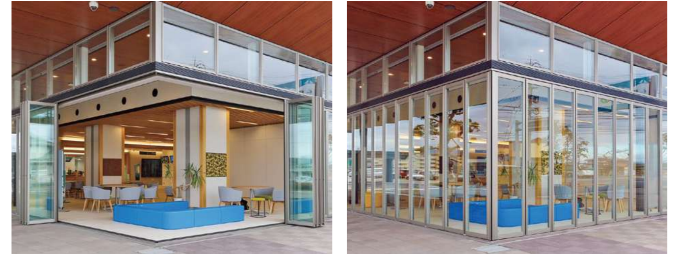
[施工事例] 築上町庁舎 コーナー枠不要で、水密性も確保。
